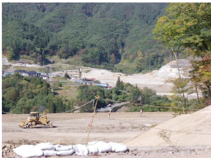
写真 3 八ツ場ダム建設予定地の山腹に造成中の居住代替地。手前が打越地区、奥が川原畑地区。2009 年 10 月 15 日撮影。
