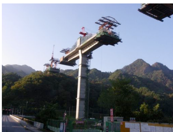
写真 5 八ツ場ダム建設予定地の湖面 2 号橋。頻繁に報道されたが、これは県道の橋であり、ダム本体工事中止後も、2010 年 3 月竣工予定で工事が進められている。2009 年 10 月 15 日撮影。
